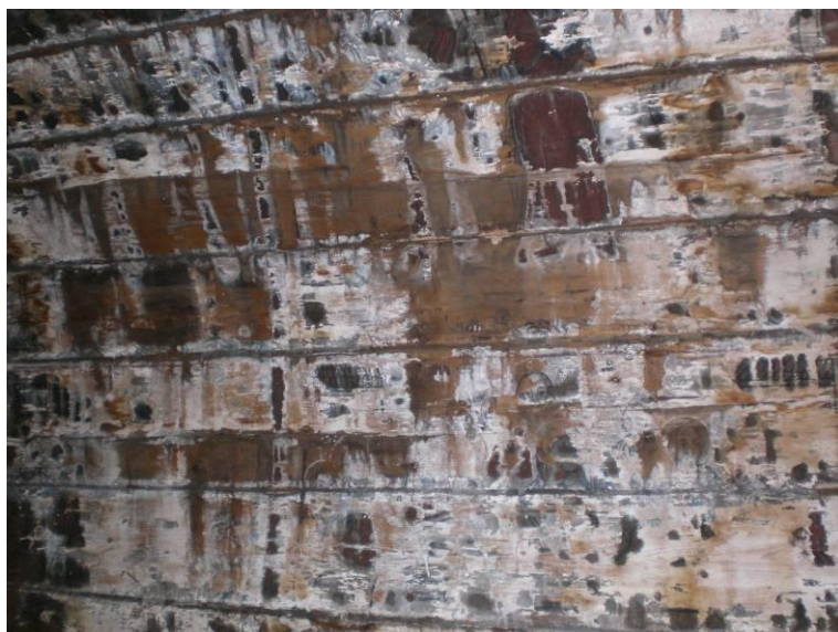
foto 8- pictura distrusă de infiltrații de apă pe peretele sudic foto 9- inscripția din timpul parohului Petru Jurcă- cca. 1875
