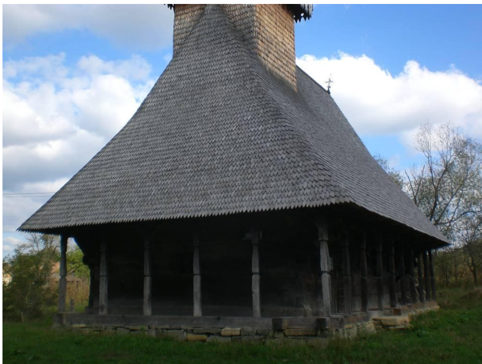
foto 8. fațadele de sud și vest protejate cu prisă
